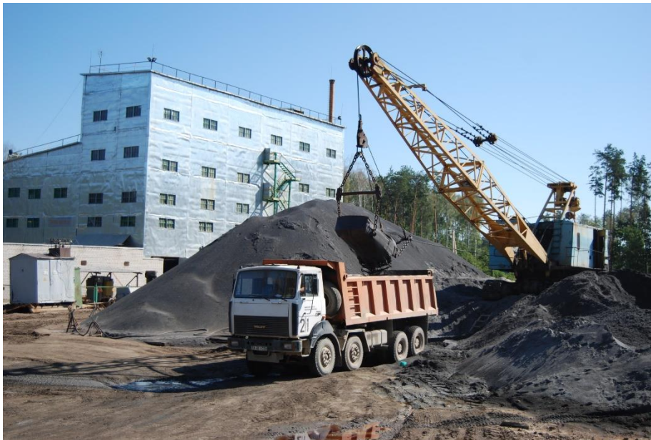
Фото 7.1.1. Збагачувальна фабрика Іршанського ГЗК
